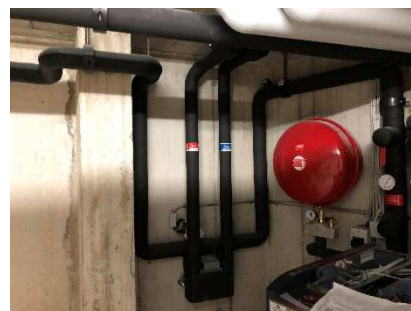
Einbindung Freecooling für Kühlung im Sommer
