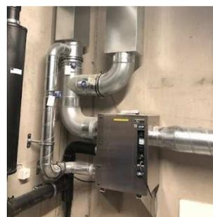
Kellerlüftung mit Adsorptions-Luftentfeuchter
