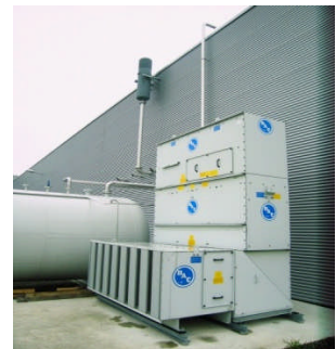
Kühlturm / Drucklufttank
