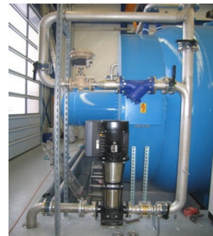
Umwälzpumpe Kühlwasserkreislauf
