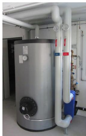
*Warmwasser-Speicher mit Plattenwärmetauscher*
