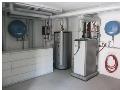
*Sole-Wasser Wärmepumpe mit Pufferspeicher*
