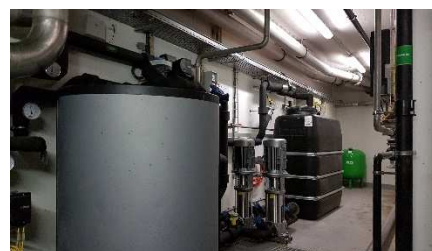
Druckerhöhungsanlage Brauchwasser
