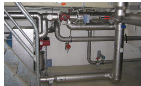
Einbau der Notkühlung mit engen Platzverhältnissen
